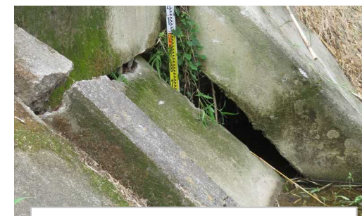
堤防張ブロックの破損(近景)
