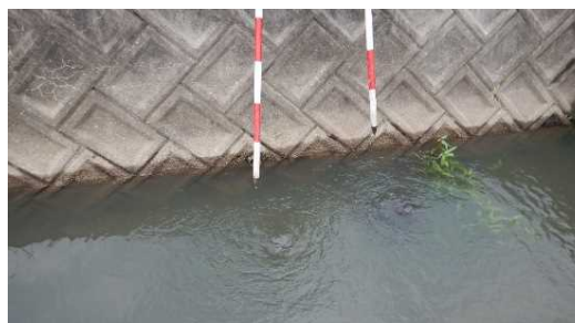
パイピングの状況。ポール先端(2箇所)
