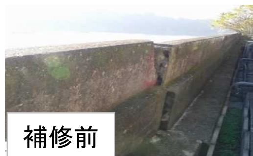
堤防張ブロックの破損(遠景)
