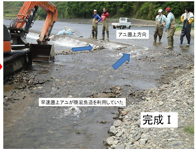
写真4 すぐ下流の砂礫を重機で埋め戻して遡上を促した
