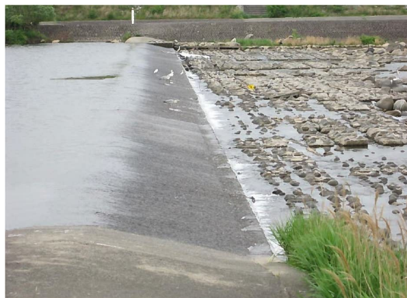
写真1 魚道がなく流れの速い堰堤 （サギがアユを待ち受けている）
