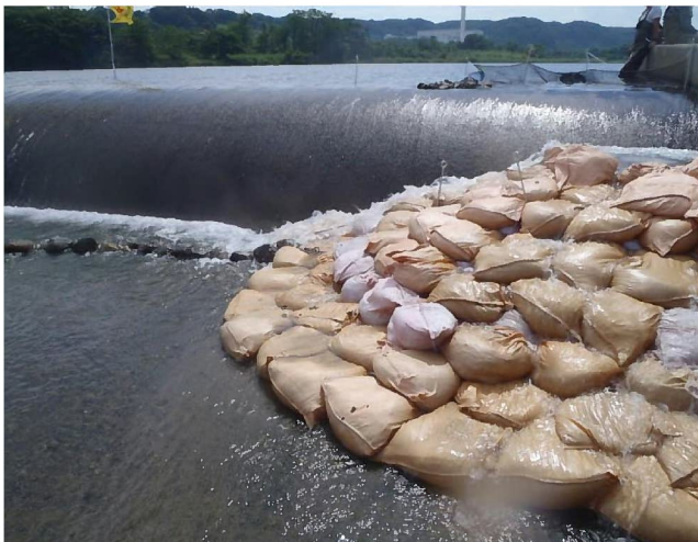
写真5 土嚢を積み上げた簡易魚道（東京都）
