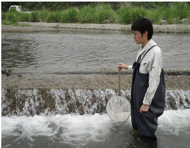
写真3 段差の高い堰堤
