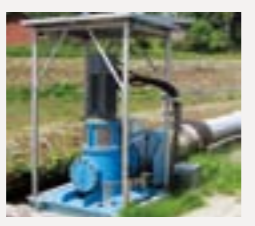
竹田市 城原井路小水力発電所
