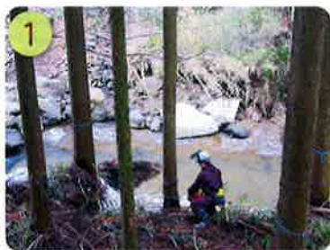
河川沿いの危険木を伐採し、流木の発生を予防(写真1)
