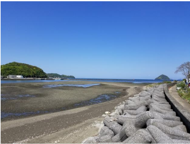
南側河岸のほとんどで砂が堆積
