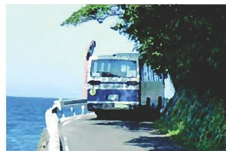
未改良区間が残る半島部の唯一の道路 （大泊浜徳浦線：白杵町）
