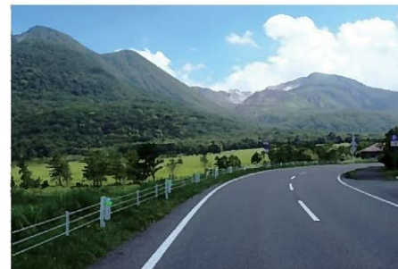
景観に配慮した防護柵に更新（やまなみハイウェイ：九重町）
