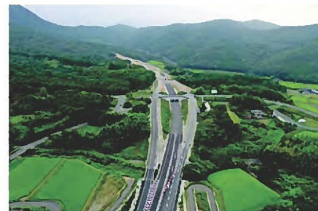
中津日田道路（田口IC付近：中津市）
