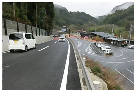
国・県・市町村が連携して計画的に整備を実施（道の駅「慈恩の滝くす」及び関連道路：玖珠町）
