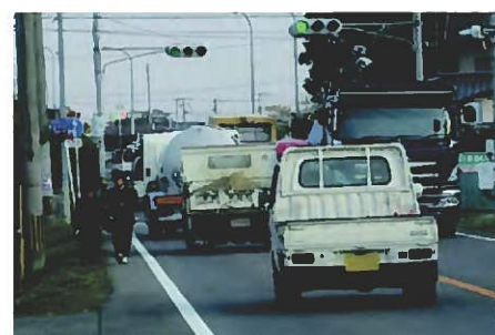
産業活動を支援する道路整備 （中津高田線：中津市）
