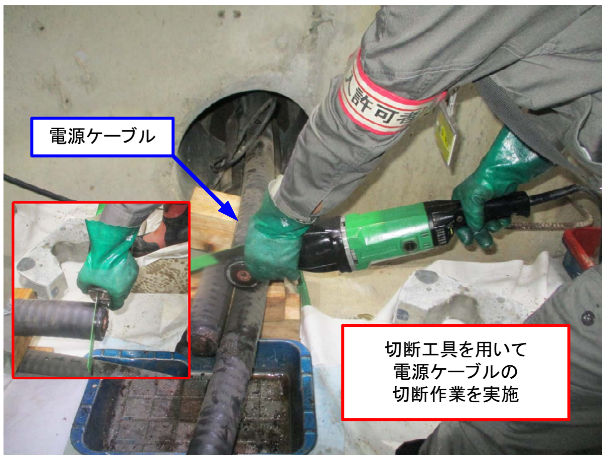
電源ケーブル切断作業時
