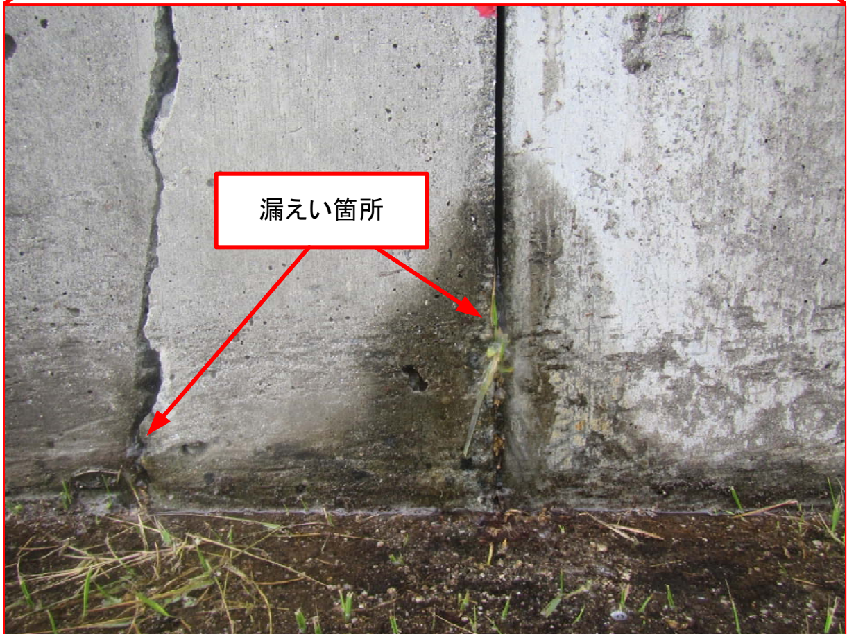
沈殿池 漏えい箇所
