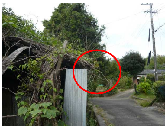
枝等が道路にはみ出している
