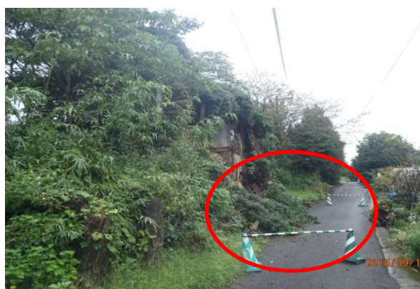
立木が倒壊し道路を一部塞いでいる
