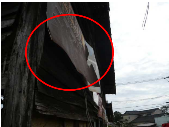
鉄製看板落下の危険性
