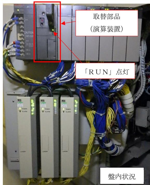
演算装置内部写真（故障箇所）
