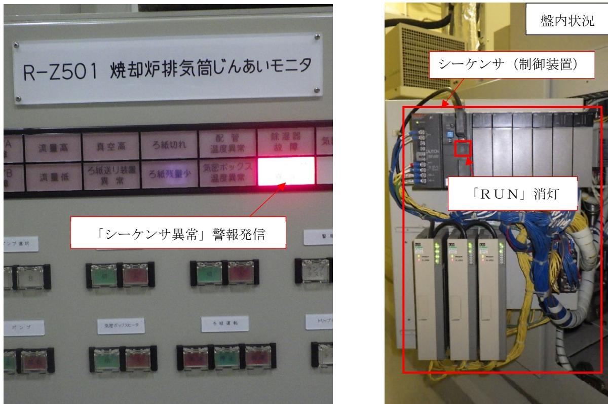
焼却炉排気筒じんあいモニタ制御装置 警報発信状況
