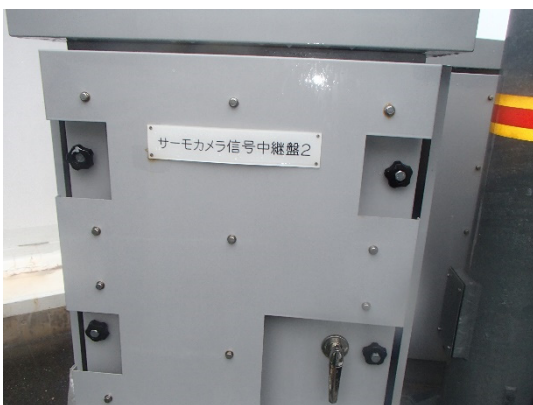
サーモカメラ信号中継盤 2 外観
