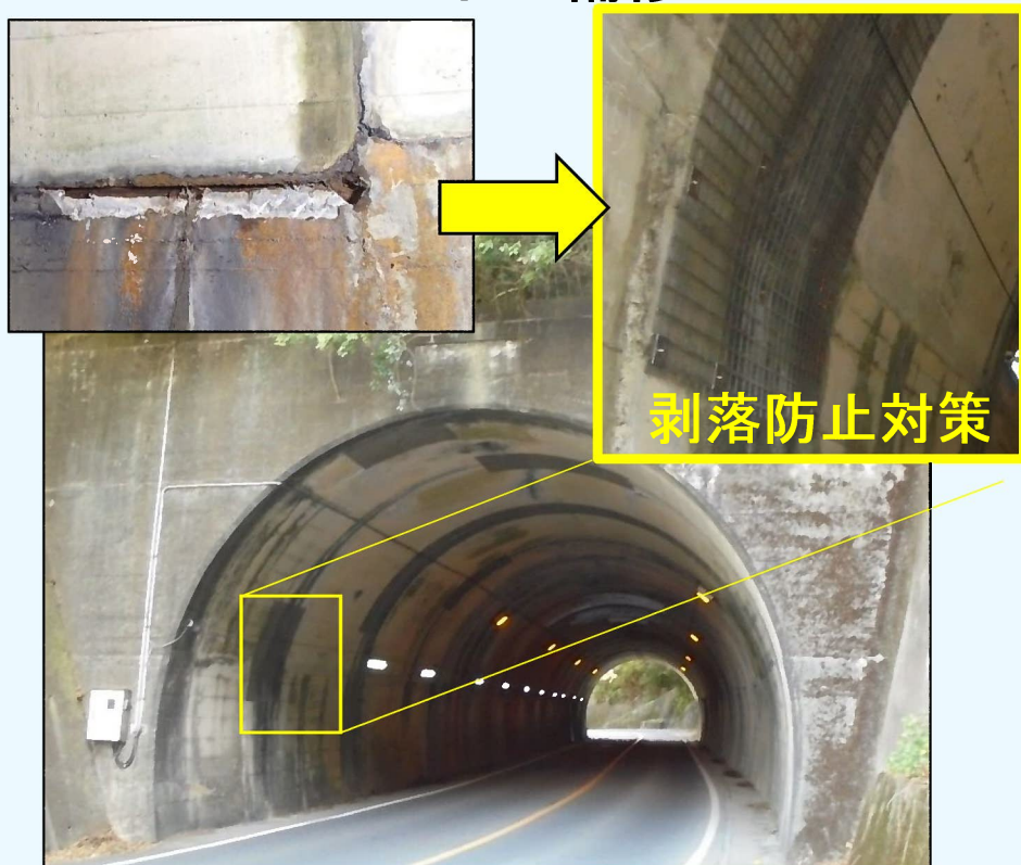
佐伯蒲江線 池田トンネル (断面修復工)
