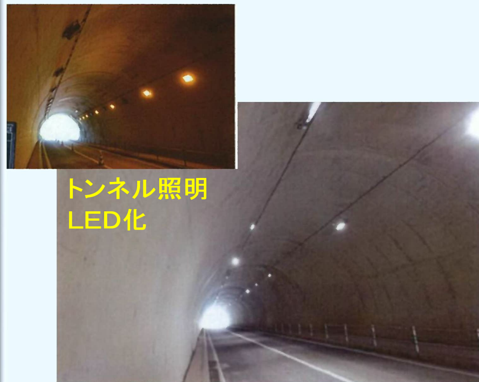
国道388号 長津留トンネル (LED照明工)
