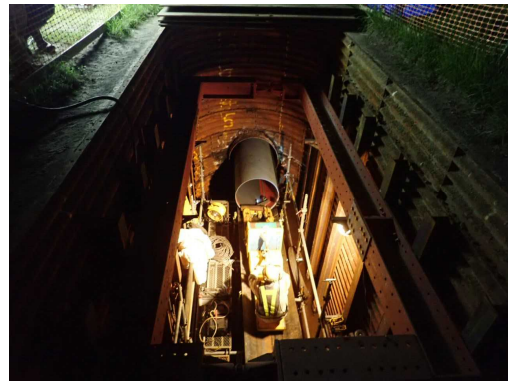
埋設管更生「パイプ・イン・パイプ工法」
