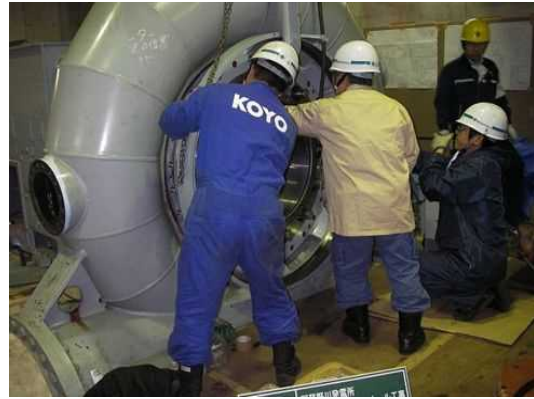
オーバーホール作業
