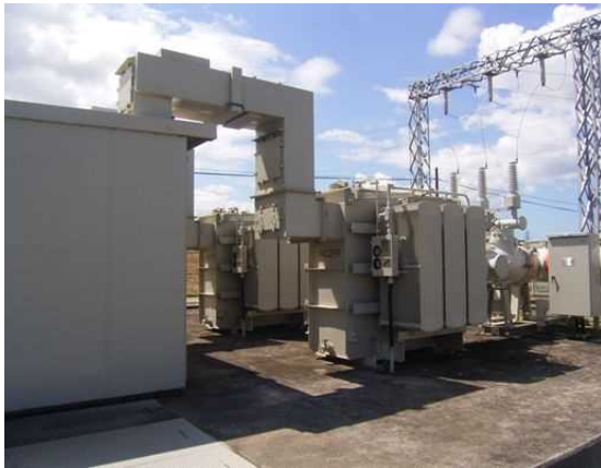
大津留浄水場受変電設備
