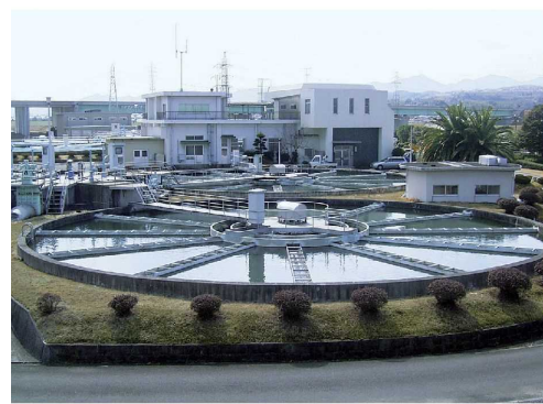
大津留浄水場
