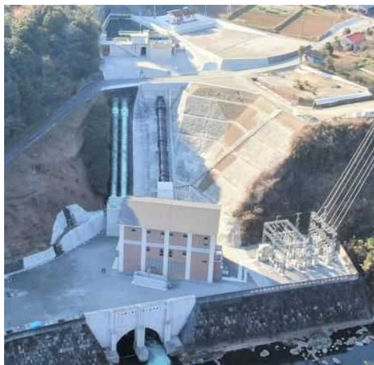
【現在の大野川発電所】
