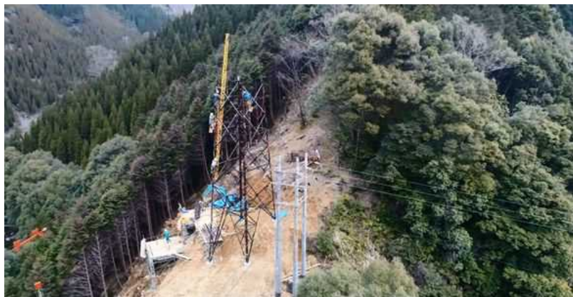
送電線鉄塔改良工事
