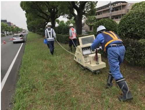
埋設管損傷調査
