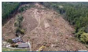
平成30年耶馬溪斜面崩壊 (中津市耶馬溪町)
