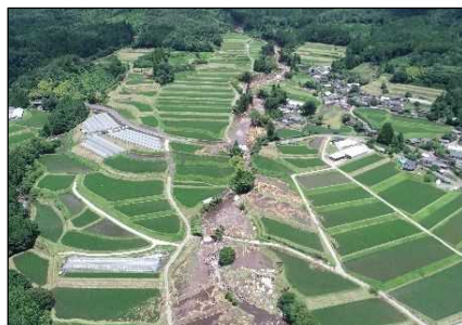
令和2年7月豪雨で被災した農地・農業水利施設（由布市）
