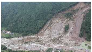
平成29年九州北部豪雨 (日田市小野地区)
