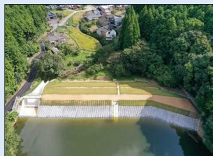
老朽化ため池の改修（大分市）
