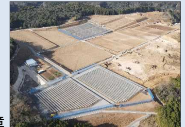
醸造用ぶどうの作付に向け 工事が続く「国営駅館川地区」
