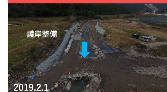
現在の状況（護岸整備）
