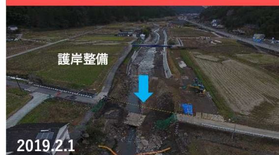
現在の状況（護岸整備）
