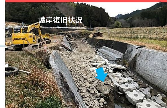
現在の状況（護岸仮復旧）
