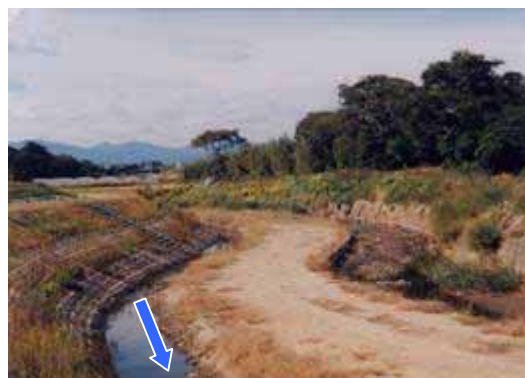
写真 4-1 0k800 付近 [ 小路橋より 380m 下流付近 ]
