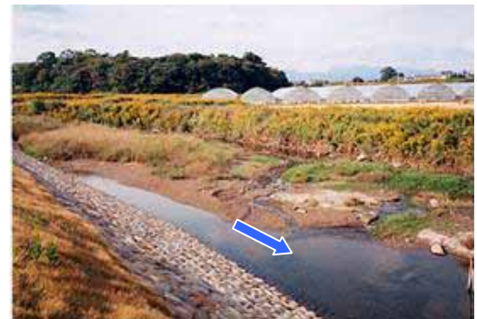
写真 2-9 下流部の河川景観 [ 小路橋より 170m 下流付近 ] (平成 14 年 10 月撮影)
