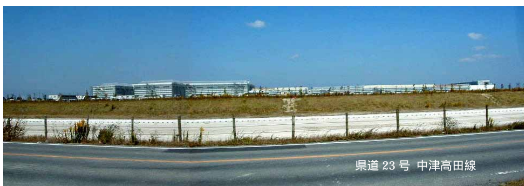
写真 1-1 河口部右岸側に建設中のダイハツ車体新工場 [ 中津市大字今津付近 ] (平成 15 年 10 月撮影)
