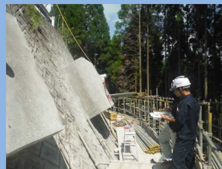
災害防除工事(保全班)の現場研修
