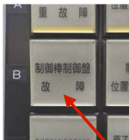
「制御棒制御盤故障」消灯
