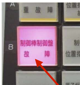
「制御棒制御盤故障」点灯
