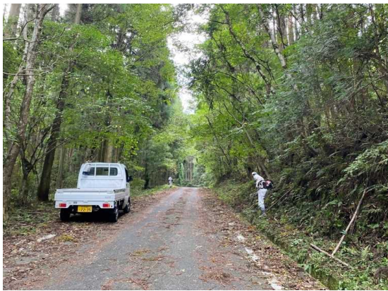
作業取りかかり
