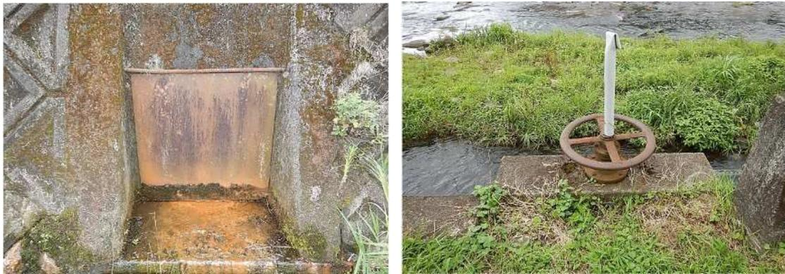
写真 2.1.7 老朽化した樋管(有田川)
