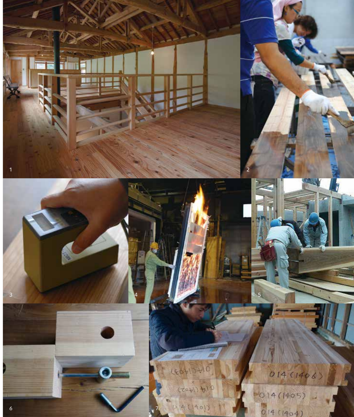
1) 古民家のリノベーション 2) 自然系の塗料で気軽に楽しみながら塗装 3) 木材の含水率を計測 4) 木のパネルの耐火性能を実験 5) 大きな断面の大黒柱 6) 木と木を繋ぐ金物 7) スギを使用した集成材
