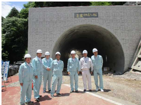
国道387号(川底工区) 道路改良事業
