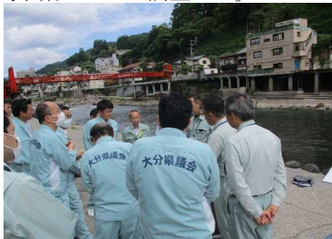
玖珠川(天瀬工区) 広域河川改修事業
