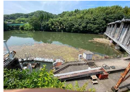
篠原ダム全景（流木多数）
