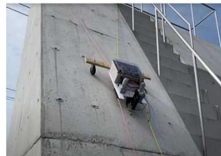
法面移動機体登攀
