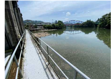
水中ドローン投入付近からの全景
