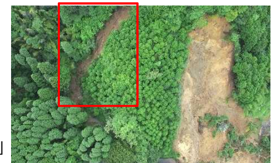
2つ目の地すべり
