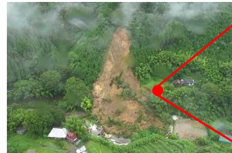
災害現場全容
