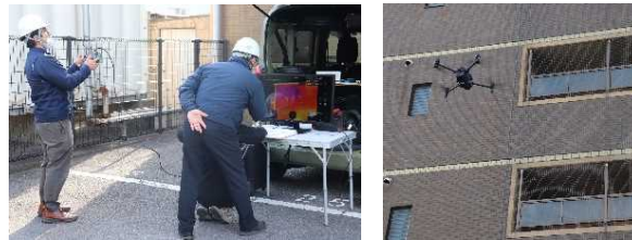
外壁点検の様子
