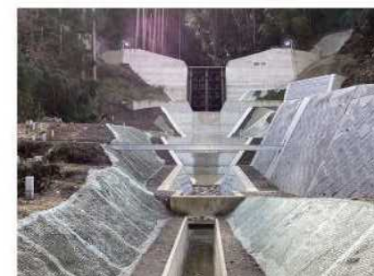
通常砂防事業 中大山川 (日田市)
