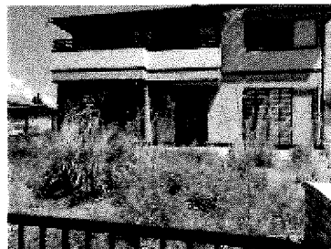
残された家は盗難被害に遭ったままであった
