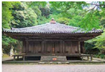
富貴寺大堂(現存する 九州最古の木造建築物)
