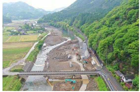
山国川河川改修工事状況
