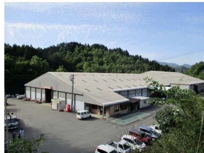
事務所兼堆肥センター
