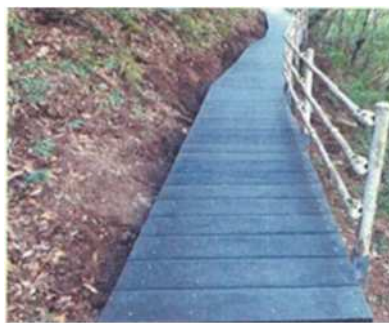
【藤河内溪谷遊歩道整備】
