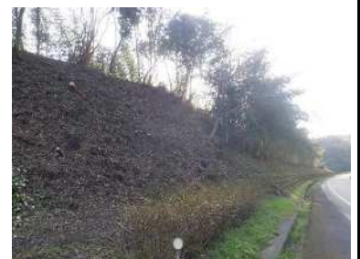
【大分空港道路支障木伐採】
