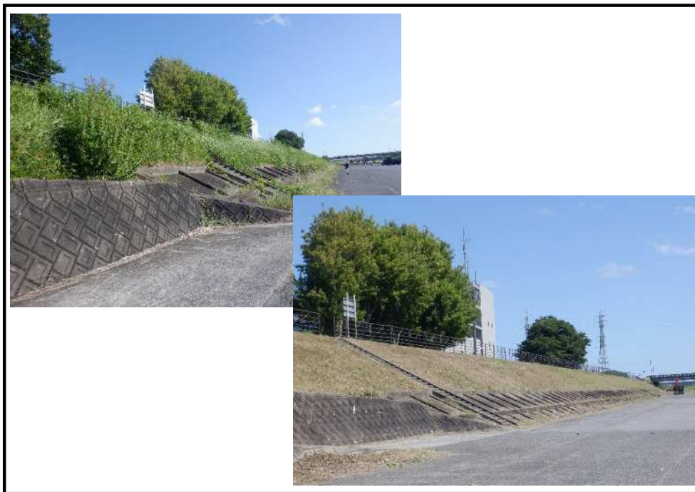
【駅館川河川清掃 作業前、作業後】
