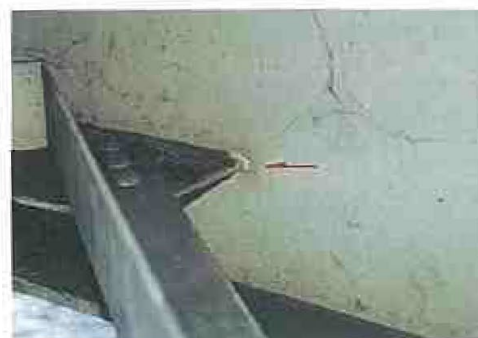
亀裂損傷例 3
