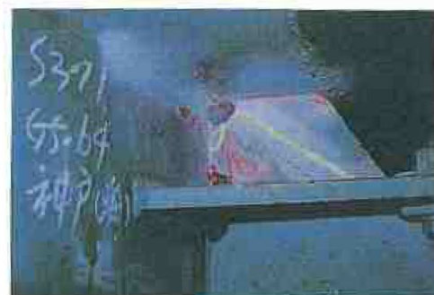
亀裂損傷例 1
