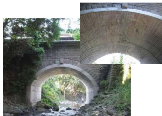
写真-2.7 輪石全体を補強している事例
