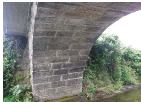
写真-2.4 目地（処理有り）
