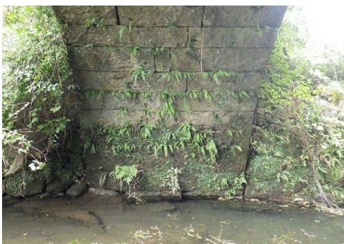
写真-2.5 目地（無処理）
