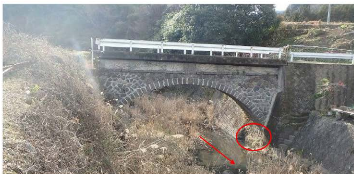
①側面(下流側)
