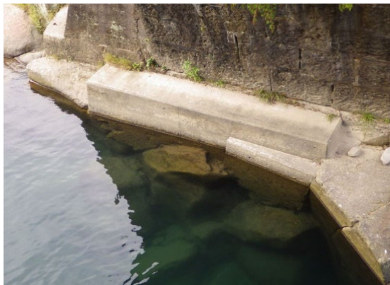
写真-2.6 基礎部分を補強している事例
