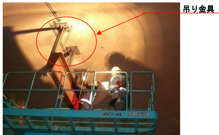
写真－解3.3 触診作業状況
