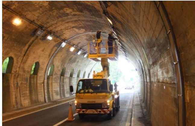
写真一解3.1 近接目視作業状況
