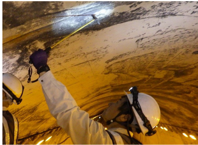
(a) トンネル本体工
