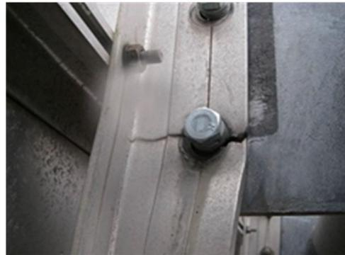
図－5.1 車両衝突による変状事例
