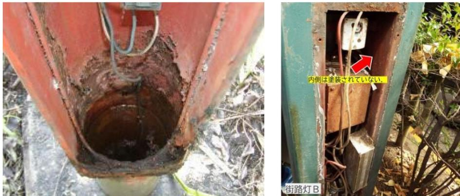
図－2. 1. 4 電気設備開口部の損傷例
