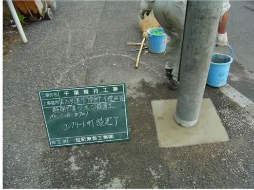
図-2. 2. 2 水切りコンクリートの施工事例
