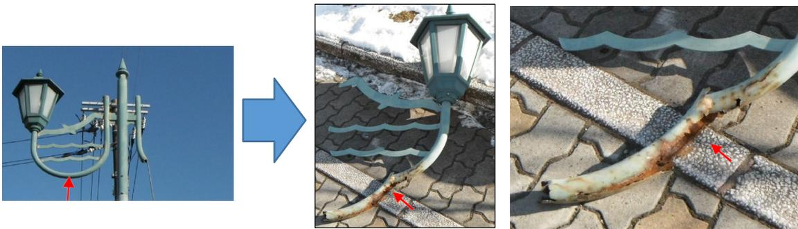
図-2. 1 特徴的な部分の腐食が進行した例
