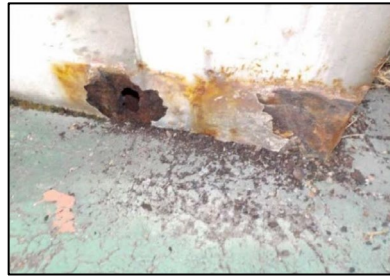
腐食片を取り除いた状態の例（地覆部）
