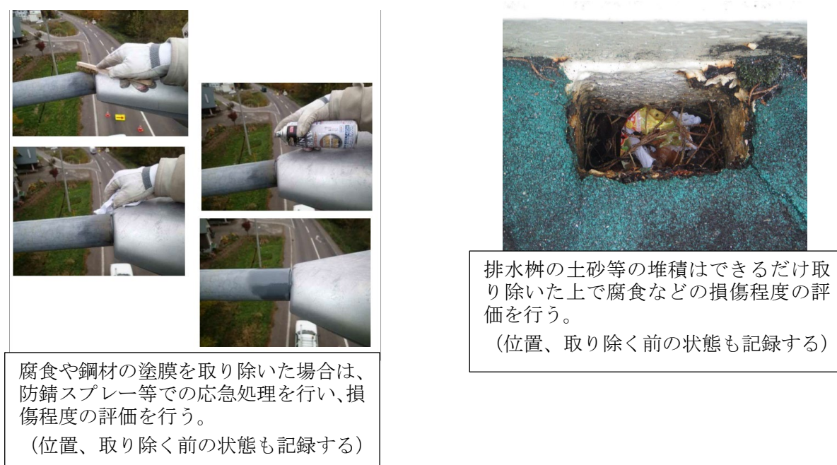
図-8. 2. 1 点検時に応急処置を行った状況例
