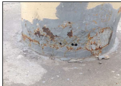
腐食片を取り除いた状態例(下部)
