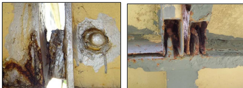
フックの溶接の状態（接合部）
