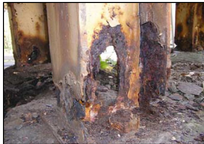
腐食片を取り除いた状態例(下部)
