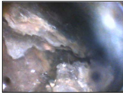
地覆内部で滞水を確認：主桁側腐食状況
