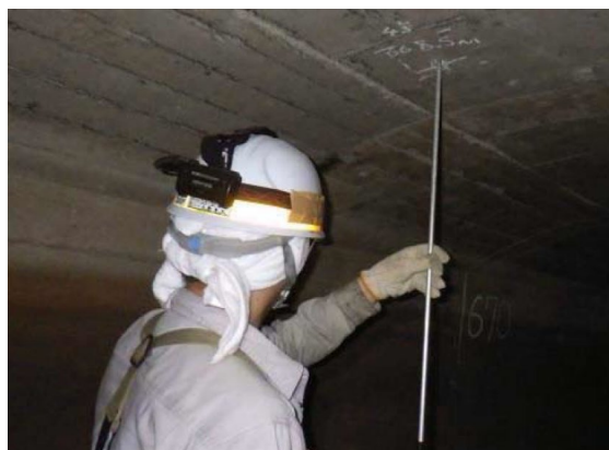
付写真 1-1 ファイバースコープを用いた状態把握状況の例
