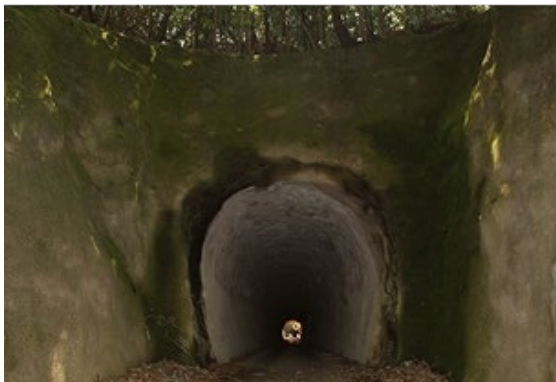
図 3-1 吹付けトンネルの例（第 1 循環隧道；高田土木事務所）
