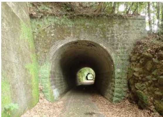
図 3-2 煉瓦積みトンネルの例（1 号厚ヶ瀬隧道；中津土木事務所）
