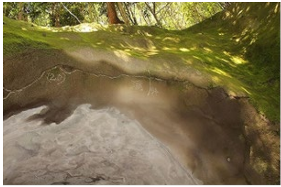
図 3-1 吹付けトンネルの例（第 1 循環隧道；高田土木事務所）
