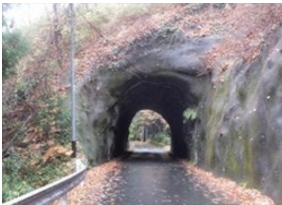
図 3-3 無巻トンネルの例（袋隧道；日田土木事務所）
