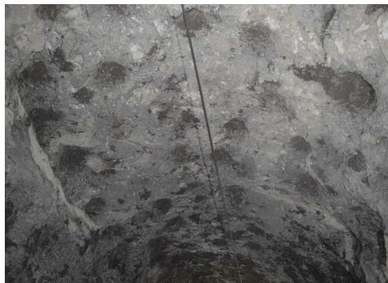
図 3-3 無巻トンネルの例（袋隧道；日田土木事務所）
