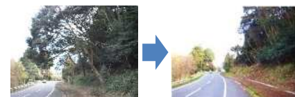
県道沿いの危険木伐採
