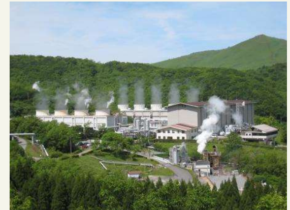
八丁原発電所（地熱）
