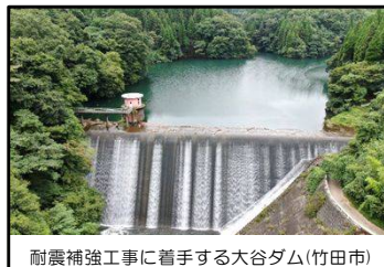
耐震補強工事に着手する大谷ダム(竹田市)
