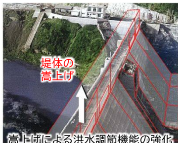
高上げによる洪水調節機能の強化 安岐ダム(国東市 S46竣工)
