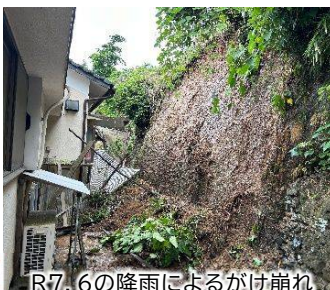
R7.16の降雨によるがけ崩れ 恵良地区(大分市)
