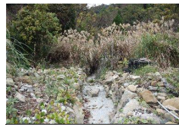
治山ダムの整備(津久見市) 着工前
