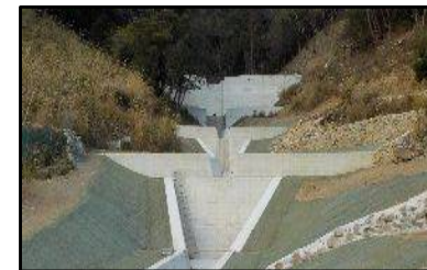
治山ダムの整備(津久見市) 竣工
