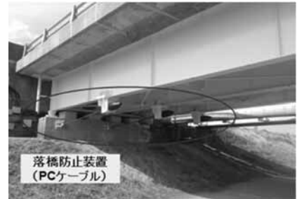
落橋防止装置の設置 (大分臼杵線 高田橋：大分市)
