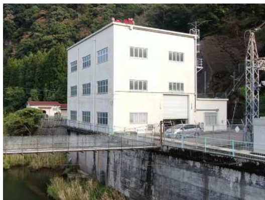
（芹川第二発電所 建屋）
