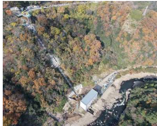
【現在リニューアル工事中の芹川第一発電所】
