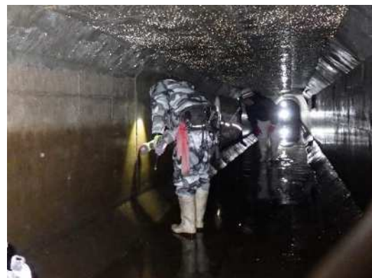
（工業用水隧道の点検）
