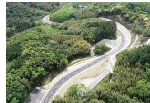
新城山香線(梅木南工区)整備状況
