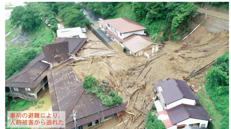
土砂災害発生前に避難した高齢者福祉施設（日田市）
