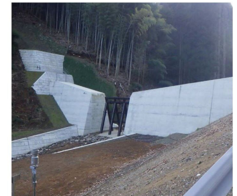
災害関連緊急砂防事業 上谷川 (日田市)
