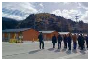
輪島市応急仮設住宅
