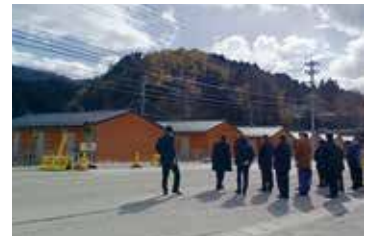
輪島市応急仮設住宅
