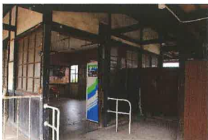
ホーム階段へ上る旧改札口 (白壁と木製窓枠が残る)
