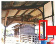
乗り場の底を支える柱(廃レール) ○にSは八幡製鉄所のマーク 1915は製造年、30はレールの重量(30ポンドレール)
