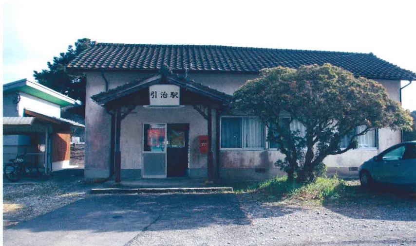
駅舎正面(令和6年3月撮影)
