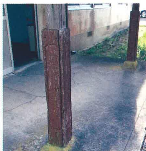
駅正面の庇を支える柱装飾が施されている。
