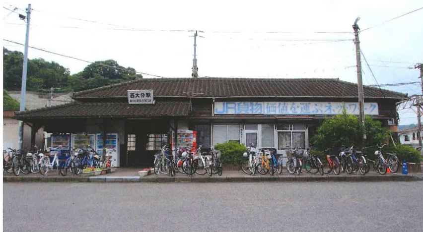
駅舎正面(令和3年9月撮影)
