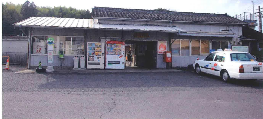
駅舎正面(令和6年3月撮影)
