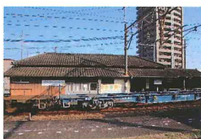
ホーム側から見た駅舎
