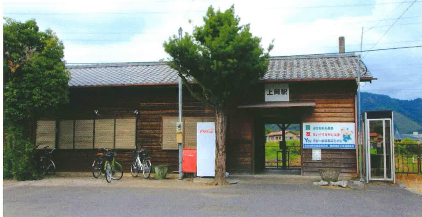
駅舎正面(令和3年9月撮影)
