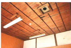
板張りの天井の穴は、だるまストーブの煙突通気口
