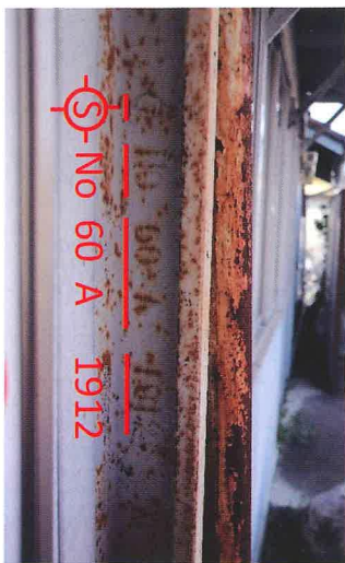
駅正面の軒を支える柱(廃レール) ○にSは八幡製鉄所のマーク 1912は製造年 60はレールの重量(60ポンドレール)
