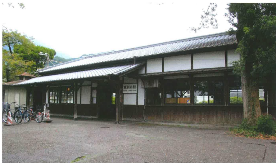
駅舎正面（令和3年9月撮影）
