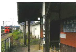
停車する列車は1日に上下各3本のみ(キハ220系による運転 平成25年7月)
