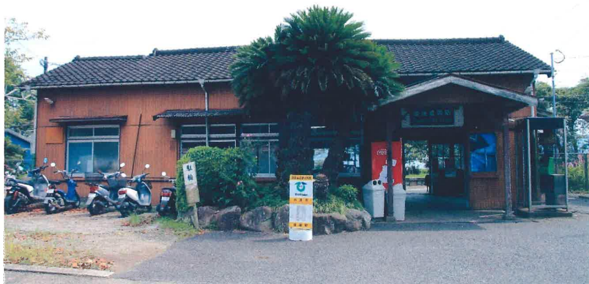
駅舎正面 (令和3年9月撮影)
