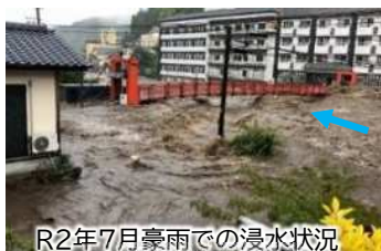
R2年7月豪雨での浸水状況 玖珠川(日田市)
