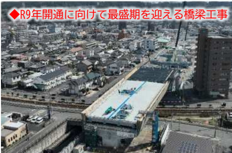
◆R9年開通に向けて最盛期を迎える橋梁工事 庄の原佐野線「下郡工区」 整備状況
