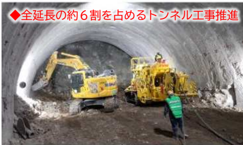
◆全延長の約6割を占めるトンネル工事推進 日田山国道路 トンネル掘削状況
