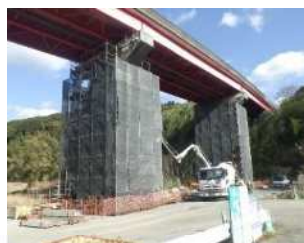
国道213号 東部橋(日出町)
