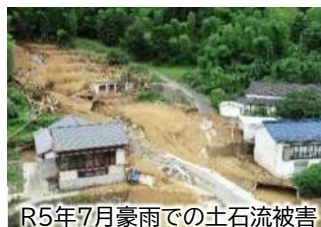
R5年7月豪雨での土石流被害 高内川(中津市)
