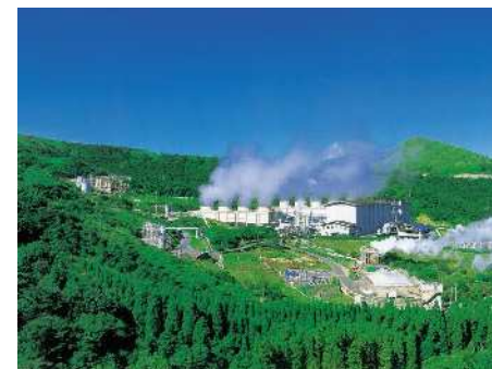
八丁原発電所 (大分県九重町)
