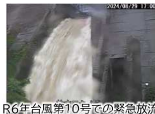
R6年台風第10号での緊急放流 安岐ダム(国東市)
