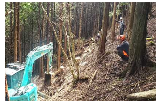
（現場での作業道作設実習の様子）
