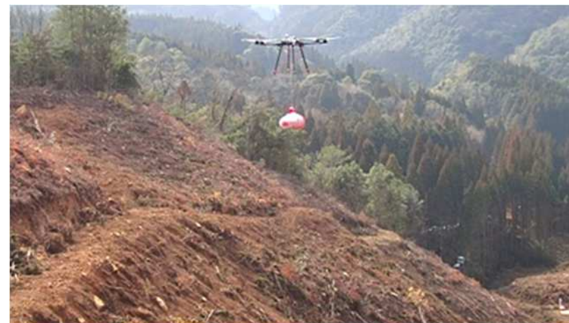
（資材運搬ドローン）
